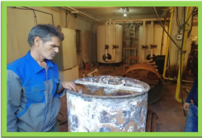
شکل ۹. تعویض تیوپها و پلیت‌ها و تعمیر کوره احتراق و رسوب زدایی
