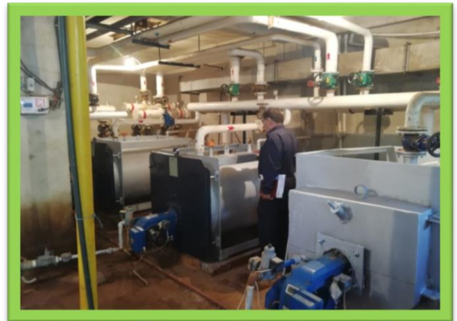
شکل ۹. تعویض تیوپها و پلیت‌ها و تعمیر کوره احتراق و رسوب زدایی
