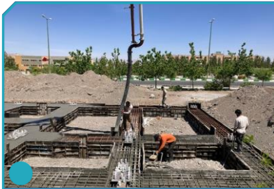
شروع عملیات اجرایی احداث ساختمان مرکز فاوا
